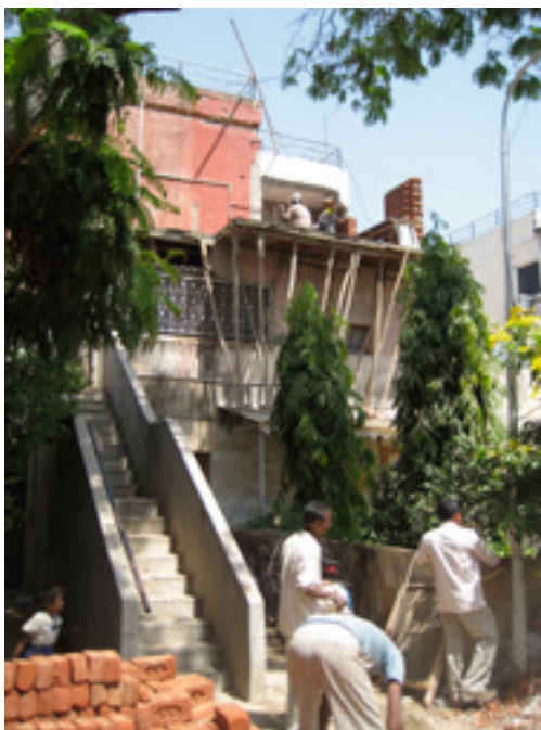
Balkrishna Doshi, woningbouwproject voor de Life Insurance Corporation, 1973-1976. Uitbreiding bovenwoning door middel van zelfbouw, Ahmedabad, 2013
