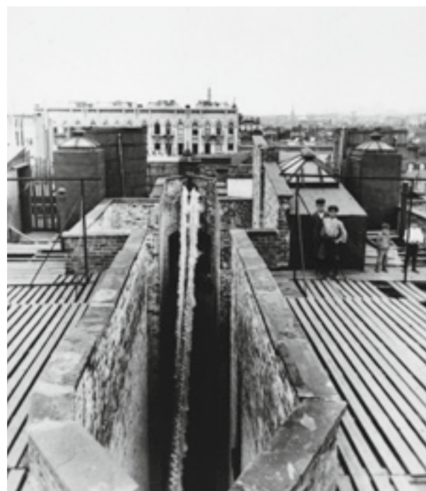
Luchtoker van een 'dumbbell tenement' gebouwd na 1887 Airshaft of a dumbbell tenement built after 1887
