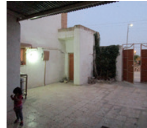
Tweelaagse woning (type 2). De patiowand is intact (boven); met toegevoegde poort om toegang te geven aan een auto (onder).
