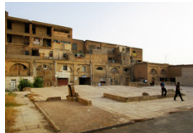
Zicht op de achterzijde van het winkelcentrum, gezien vanaf het noordelijke plein View of the back of the commercial centre, as seen from the northern square
