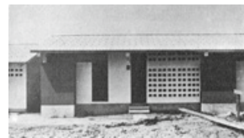
Herziene versie van woningtype B01/A03 (boven) en woningtype B04 (onder) Revised version of dwelling type B01/ A03 (above) and dwelling type B04 (below)
