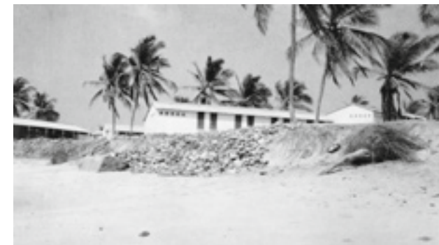
Erosie van het strand van Awudung. De Tema Development Company plaatste stenen in een poging de palmbomen en huizen te beschermen, 1966. Erosion on the beach in Awudung. Stones have been placed by the Tema Development Company in an effort to protect the palms and houses, 1966.
