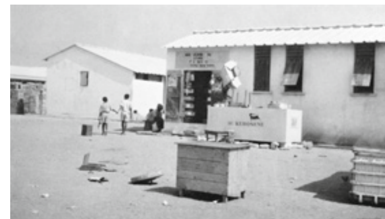
Een keuken van een type A compound woning werd verbouwd tot winkel, 1966 A kitchen of a Type A compound converted into a shop, 1966
